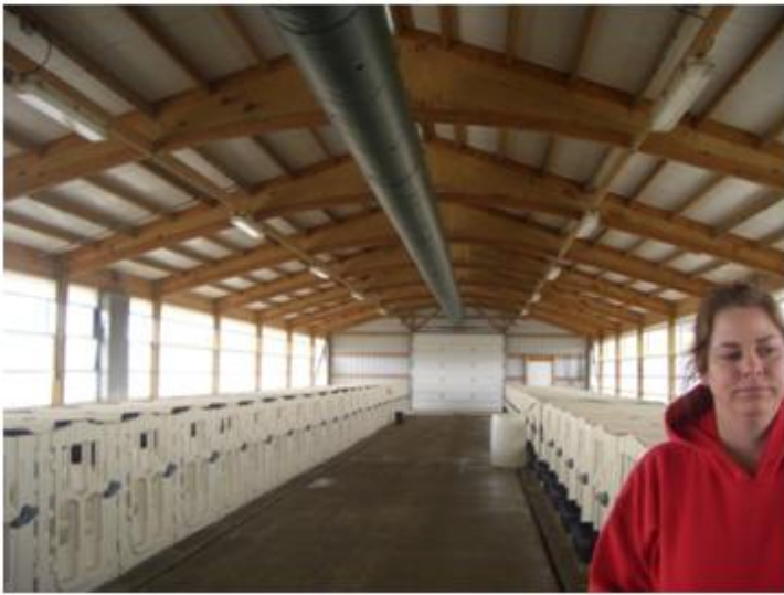
* 哺育舎の陽圧ダクト換気システム
