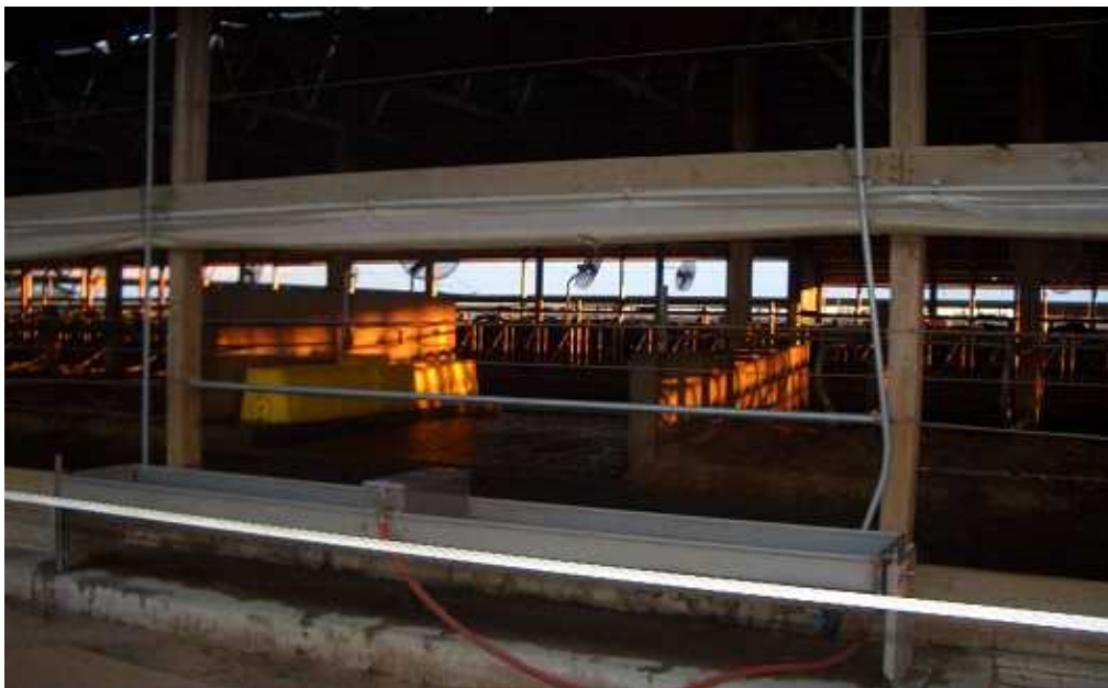
水槽の併設 暑熱対策や乾物摂取量の向上のため横断通路と牛舎外側の2箇所
